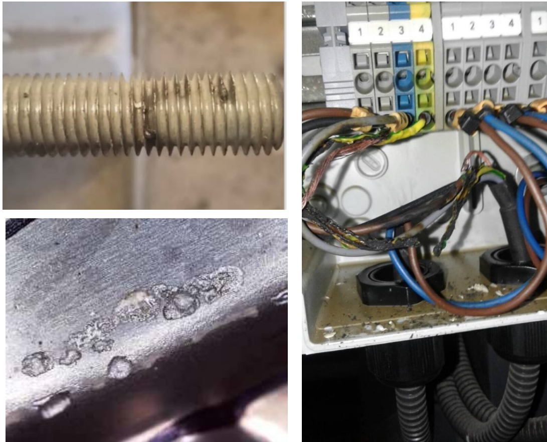
Рисунок – 22. Последствия неправильного подключения «массы» сварочного аппарата
